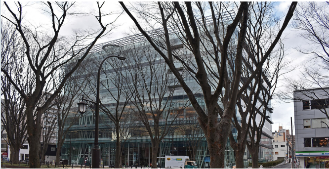
센다이 미디어테크 외관 — 유리·철골 튜브 구조의 공공 도서관·갤러리 복합시설
